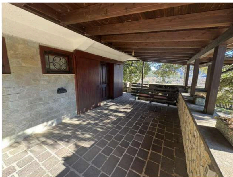
vista dell'immobile – tettoia in legno sul fronte d'ingresso (zona villa preesistente)
