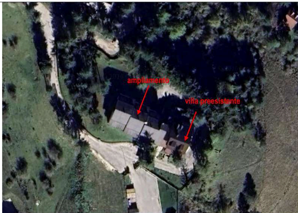
- vista dell'immobile con la strada di accesso (fonte: Google Earth)
