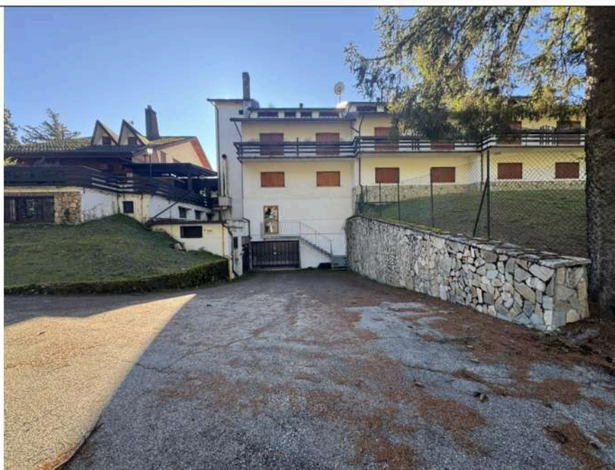
- vista posteriore dell'immobile (lato nord) – accesso garage
